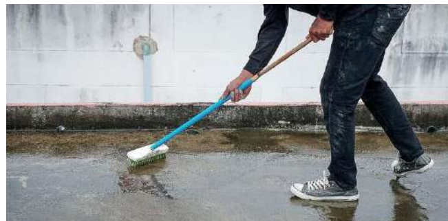
Título: Limpieza de hormigón
