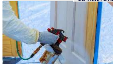
Título: Lacado de puertas de madera Fuente: https://presupuestosgratisonline.com/servicios/lacado-de-puertas/
