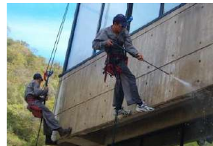
Título: Mantenimiento en paredes, muros y antepechos
